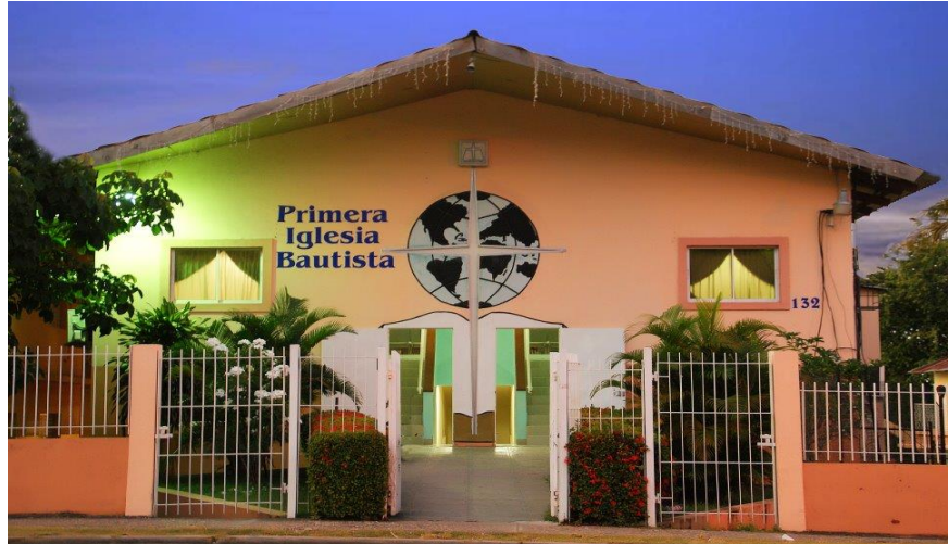
Fachada frontal de la Primera Iglesia Bautista de Puerto Plata, Calle Beller,
