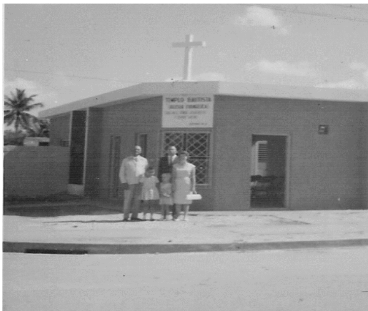
Primer Local de la Iglesia Bautista Ozama (1965), situado en la intersección de las calles Costa Rica y Aruba del Ensanche Ozama.
